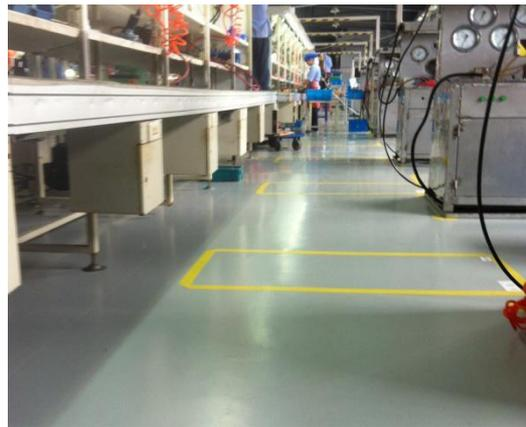
**项目效果：**因通道地面多车辆走动、运输压力，地面需耐磨抗压，对通道进行经打磨去除原地坪，使用对耐磨、防静电等均做了特殊处理的专项定制产品，解决了车间地面的问题产生，无甲醛VOC，保证生产过程不间断，降低生产成本，完工后整体形象提升。
